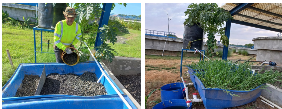
Figura 5. Humedales artificiales de afino, pasto Tanner. Generación de agua postratada para riego con nutrientes
