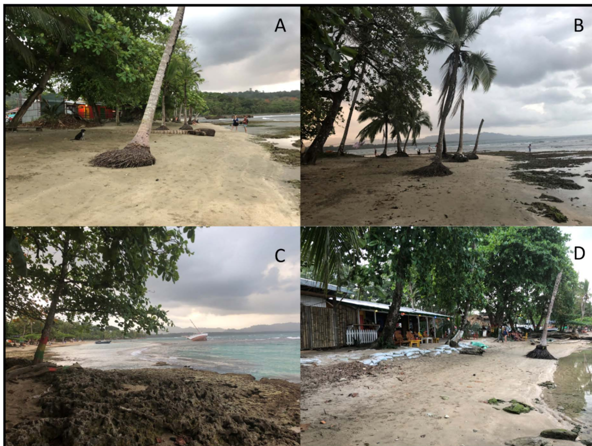
Figura 3. Evidencias de procesos erosivos en Puerto Viejo de Limón. A, B y C) palmeras caídas o muertas en pie. A, B y C) exposición de plataforma litoral levantada durante el terremoto de Limón en 1991. D) Colocación de Sacos de arena para contener la erosión frente a un restaurante. Fotografías: Gustavo Barrantes, agosto del 2018. Figure 3. Evidence of erosive processes in Puerto Viejo, Limón. A, B, and C) fallen or standing dead palm trees. A, B, and C) exposure of coastal platform uplifted during the 1991 Limón earthquake. D) Placement of sandbags to contain erosion in front of a restaurant. Source: Photographs: Gustavo Barrantes, August 2018.
