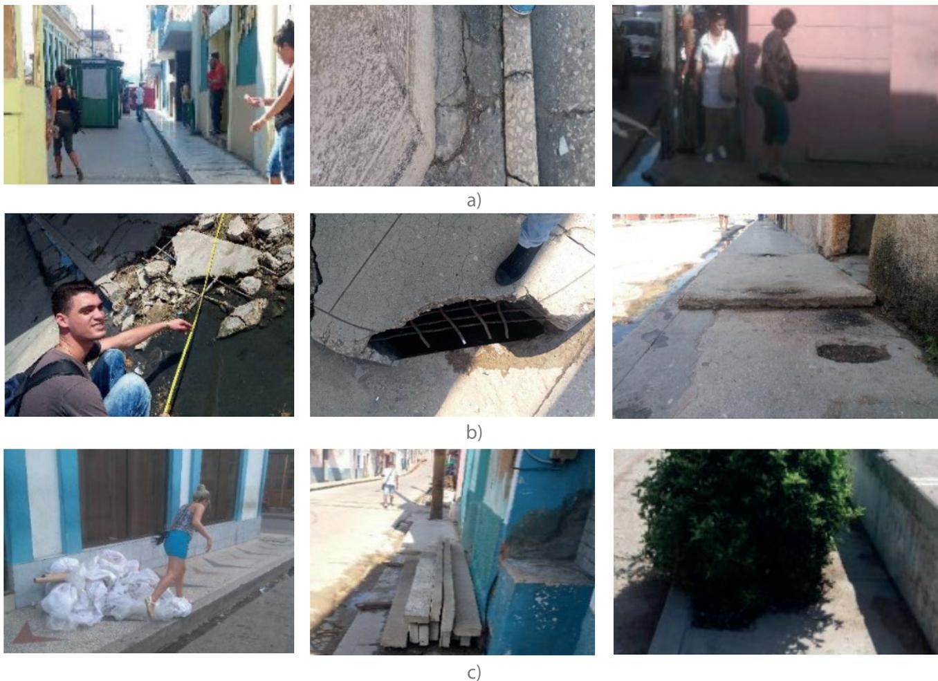
Figura 1. Problemas funcionales identificados durante el diagnóstico: a) ancho de aceras insuficiente; b) mal estado de conservación de la superficie de caminata; c) presencia de obstáculos
