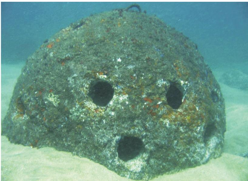
**Fig. 7.** Arrecife tipo reefball (domo) ubicado sobre fondo arenoso a 6 m de profundidad en ANP Complejo Los Cóbanos. Aproximadamente a 3-4 meses de su colocación. / **Fig. 7.** Reefball (dome) located on sandy floor at 6 m deep at Los Cóbanos NPA. 3-4 months after placement approximately.
