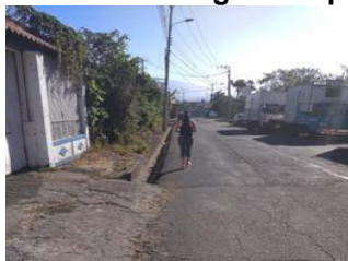
Figura 3 Inseguridad por falta de aceras en Alajuelita Centro
